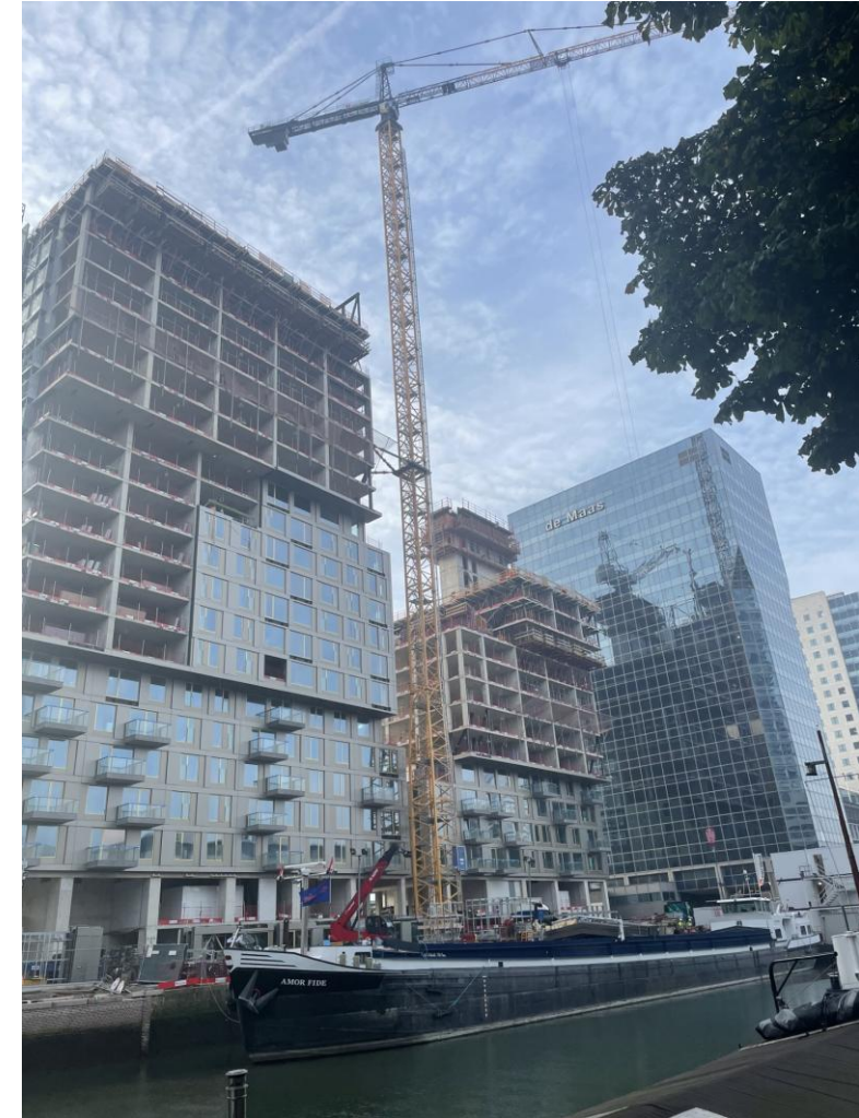
Voorbeeld drijvende opslag wapeningsstaal project R'dam
